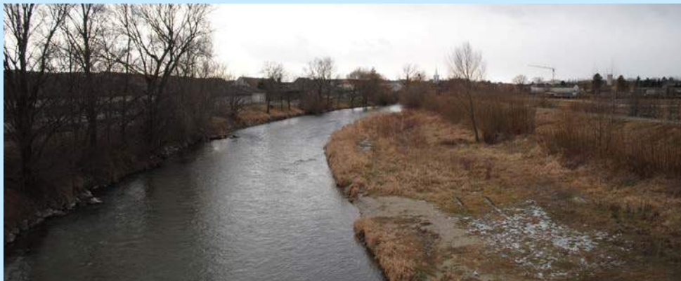
Abb. 4.6.26: Derzeitige Situation der Leitha
